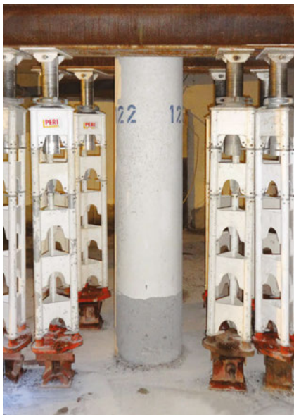
In der Bau-phase sind oft provisorische Abstützungen notwendig.
