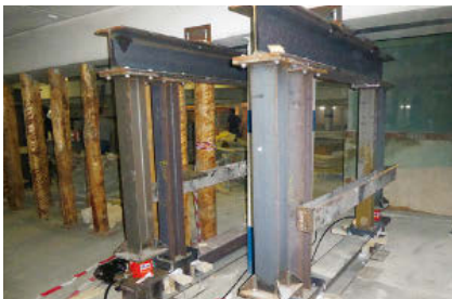
Pressen drücken Stahlunterbauten nach oben, um Unterzüge temporär abzustützen.
