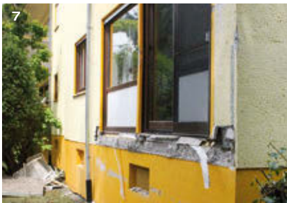
Abb. 7 Im Juli dieses Jahres stürzte ein Balkon in Nußloch im Rhein- Neckar-Kreis ab. Laut Gutachten deutet alles auf durchgerostete Bewehrungsseisen hin.
