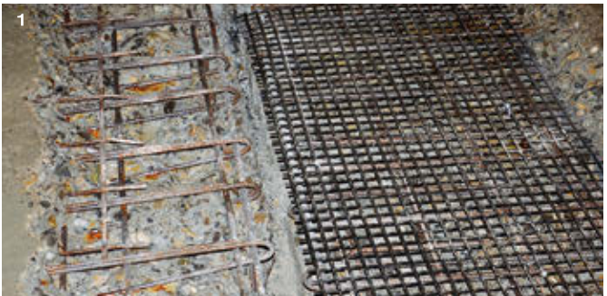
Abb. 1 Die Textilbewehrung ergänzt die herkömmliche Bewehrung aus Stahl
