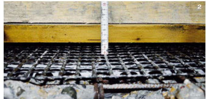
Abb. 2 Bewehrungen mit Carbon eignen sich bei sehr flacher Einbauhöhe
