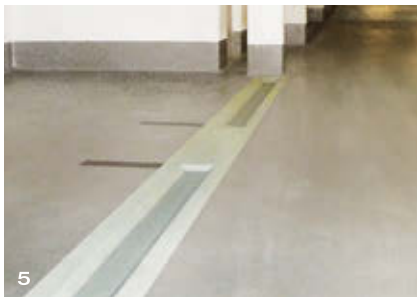
Abb. 3 Verdunstungsrinne mit eingelegter Textilbewehrung. Eine Verlegung der Rinne war aufgrund der vorhandenen Gefälleverhältnisse nicht möglich.
