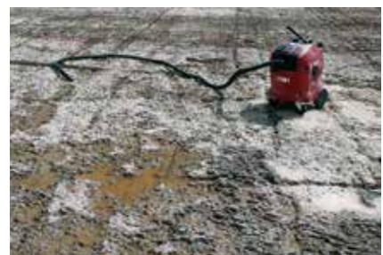
Die Betonfläche unter der Deckschicht wurde saniert und Bewehrungen ergänzt.
