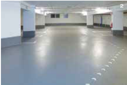
Kathodischer Korrosionsschutz in einer Tiefgarage in München.
