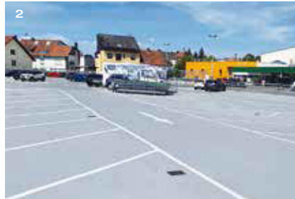
Großflächiger Einsatz des Oberflächenschutzsystems Polyurea auf dem Parkdeck in St. Wendel.
